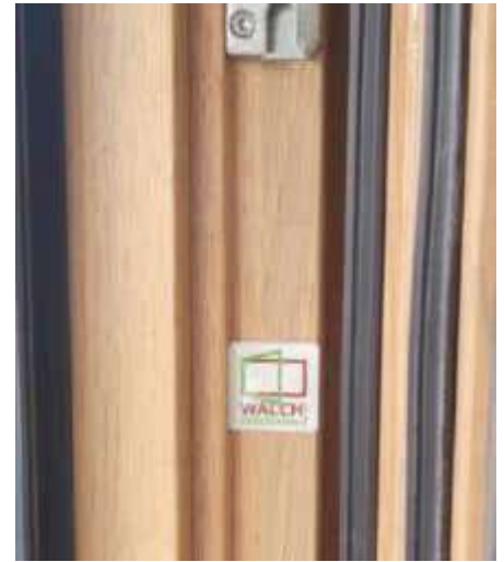
Der NFC-Chip wird in den Rahmen eingeklebt
